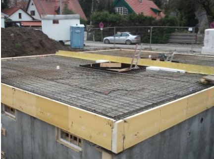
Abb.: Filigrandecken (Elementdecke)
