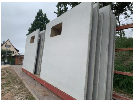
Abb.: Doppelwände
