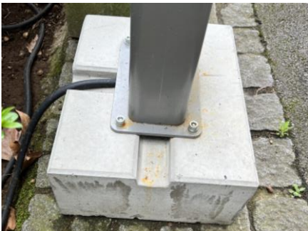
Abb.: E-Ladesäulen Fundament
