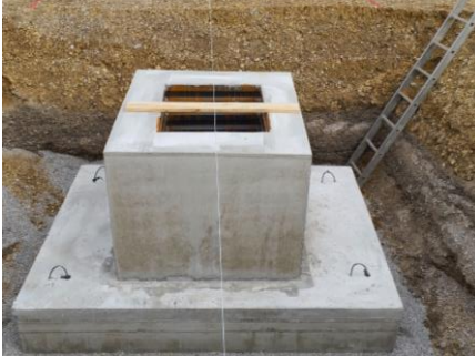
Abb.: Köcher- und Punktfundament
