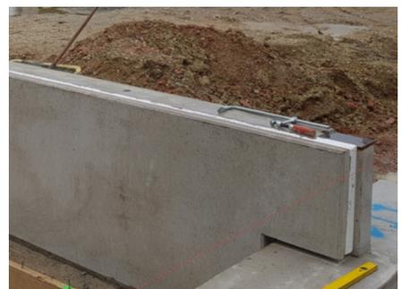
Abb.: Isolierte Wände (Sandwichwände)
